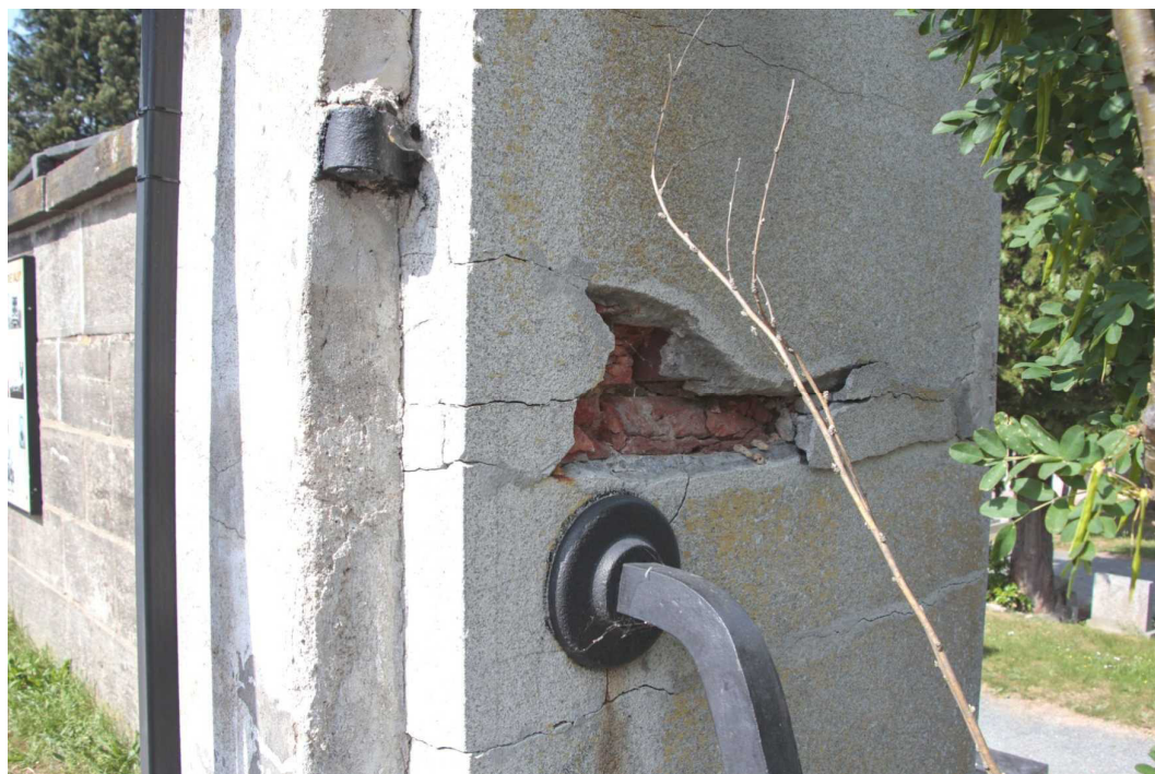
10. Detailní pohled na statickou poruchu u pilíře vjezdové brány a na zachovalý mohutný závěs původního křídla brány.
