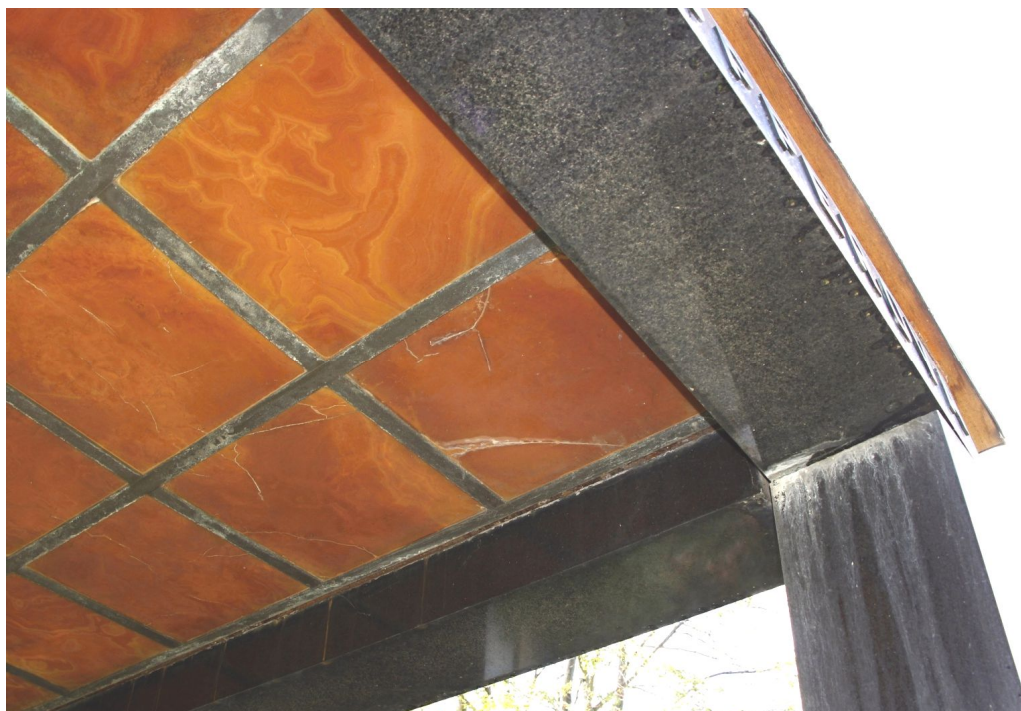
31. Celkový pohled zespoda na podhled z průsvitných onyxových desek se zřetelným poškozením v podobě prasklin a solných výluhů z dešťových srážek.
