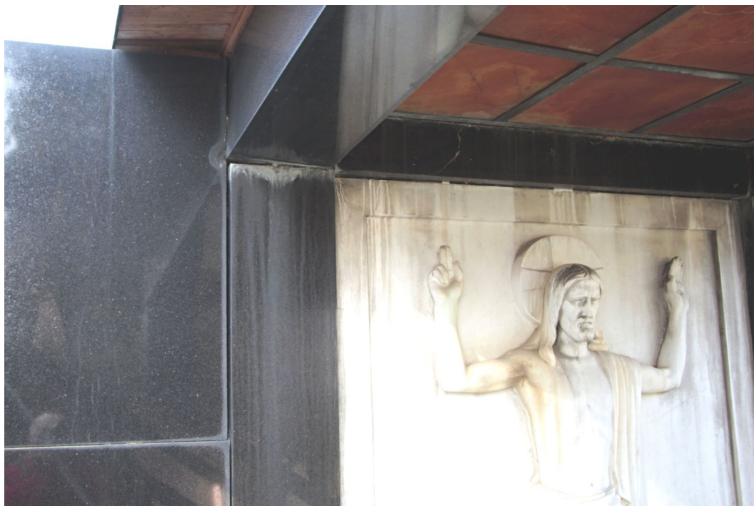
25. Celkový pohled na deformace a vlhkostní poruchy ve styku zadních pilířů, nápisových desek a bočních průvlaků.
