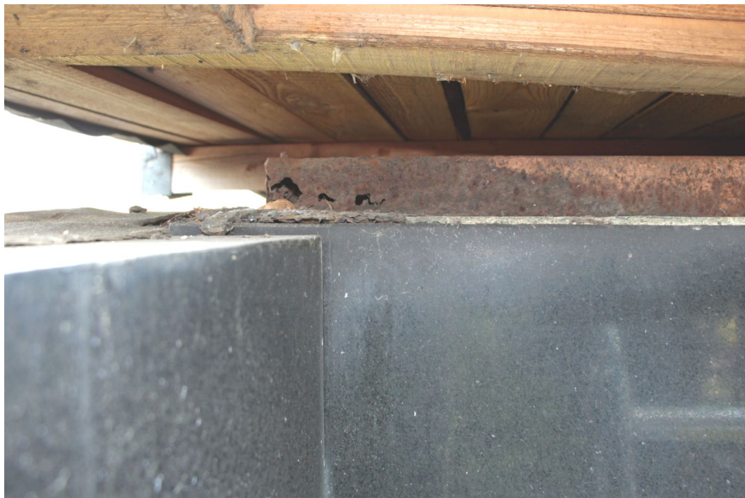
16. Detailní pohled pod provizorní střechu hrobky u hřbitovní zdi s částí silně zkorodované pozednice – nosníku U 60.
