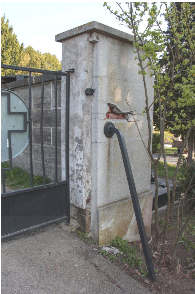
9. Celkový pohled na statické poškození pilíře vjezdové brány a historickou kovanou vzpěru.
