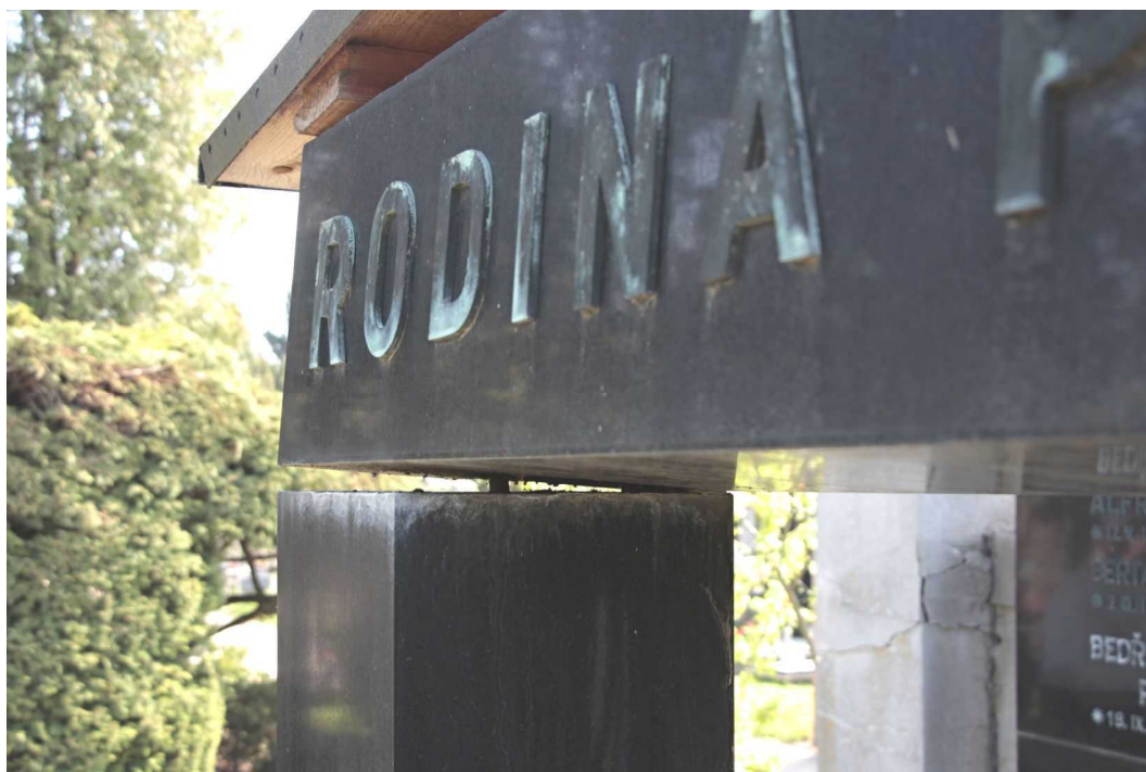
24. Detailní pohled na deformaci ve styku pilíře a čelního průvlaku (architrávu) hrobky zajištěný nerezovým čepem.
