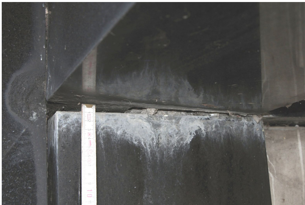
26. Celkový pohled na deformace a vlhkostní poruchy ve styku zadních pilířů, nápisových desek a bočních průvlaků.
