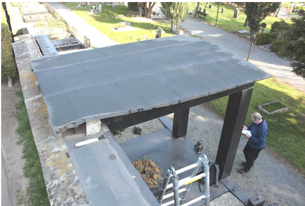
13. Celkový pohled na střechu hrobky provizorně zakrytou asfaltovou krytinou na bednění z prken.
