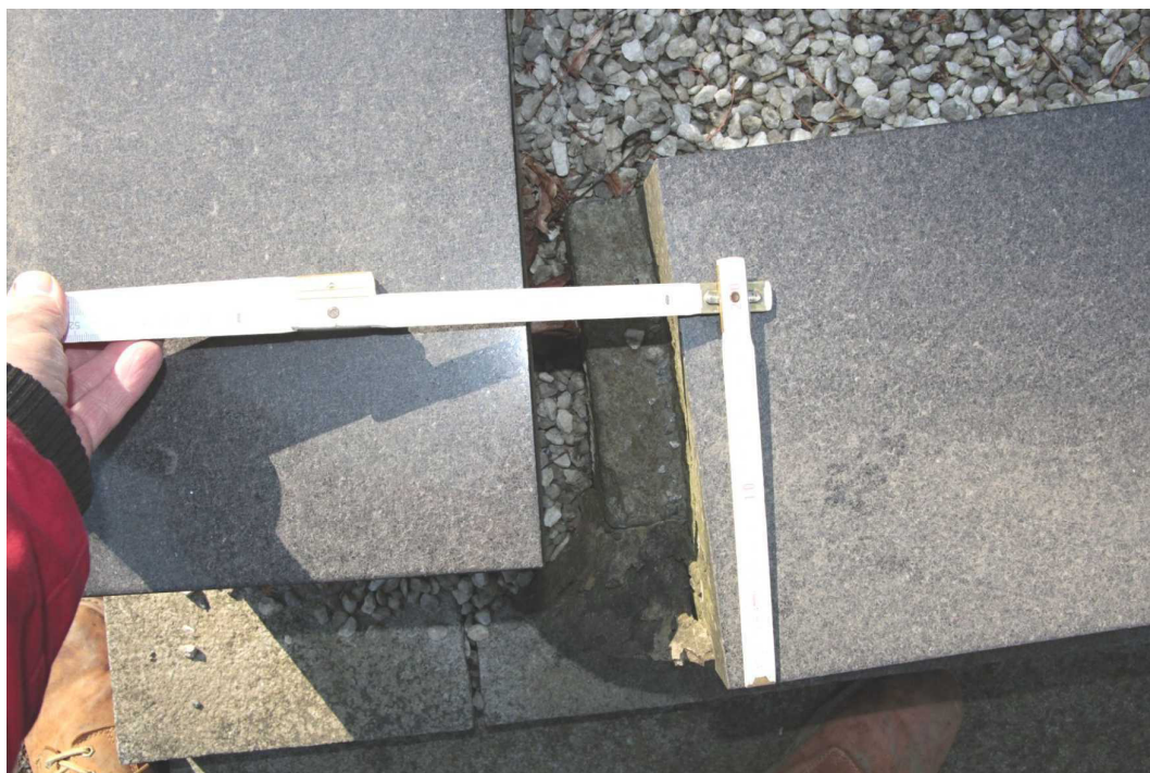
17. Deformace v řádu centimetrů u prahových kamenných bloků u bočního pole hrobky s viditelným poškozeným zámkem.
