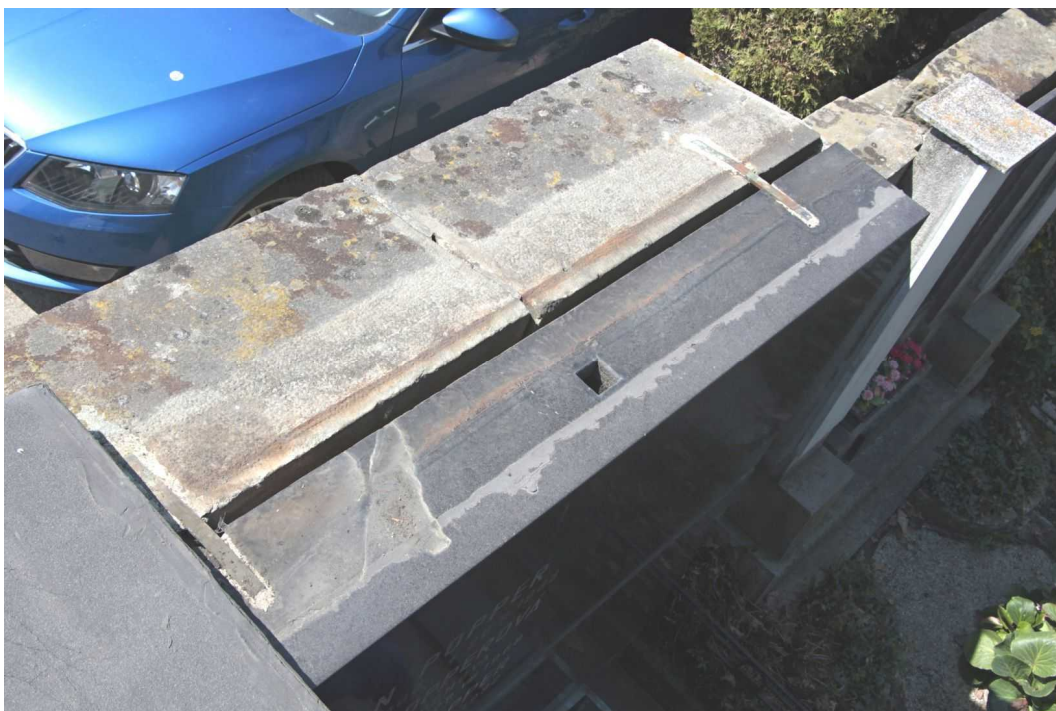
14. Celkový pohled na styk koruny hřbitovní zdi a nápisového bloku hrobky spojený kamenickými skobami a s otisky původního oplechování. Uprostřed kónický otvor pro manipulaci s kamenným blokem.
